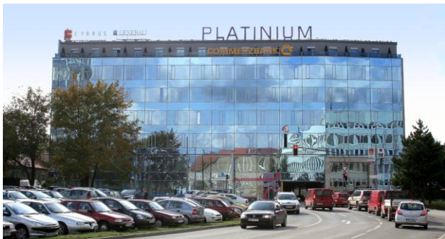
Administrativní budova Platinum, Brno, ČR
